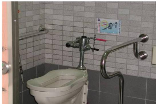
圖 4.5 馬桶加裝二段式沖水器
