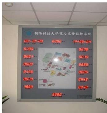
圖 4.1 電力監控系統
